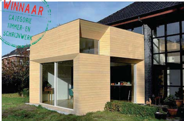
Het lijnenspel van de uitbouw en de technische uitdagingen die daarmee gemoed waren, konden de jury van de Schrijnwerk Awards meer dan bekoren
